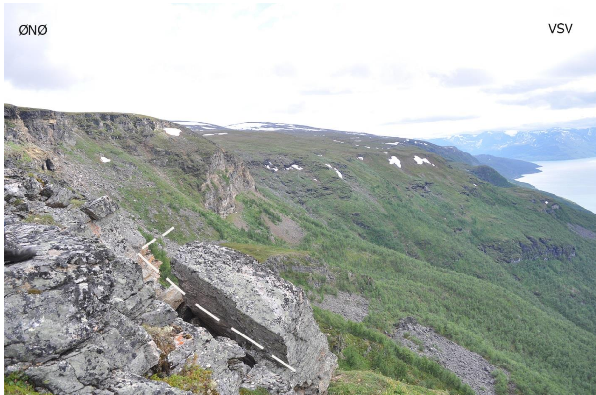
Fig. 37 Syner ei blokk som er skild frå terrassen i den sørlige delen av skredområde der blokka er skild frå berggrunnen ved to opne sprekker i bakkant. Legg merke til at blokka er skild frå berggrunnen langs klare lineære flater
