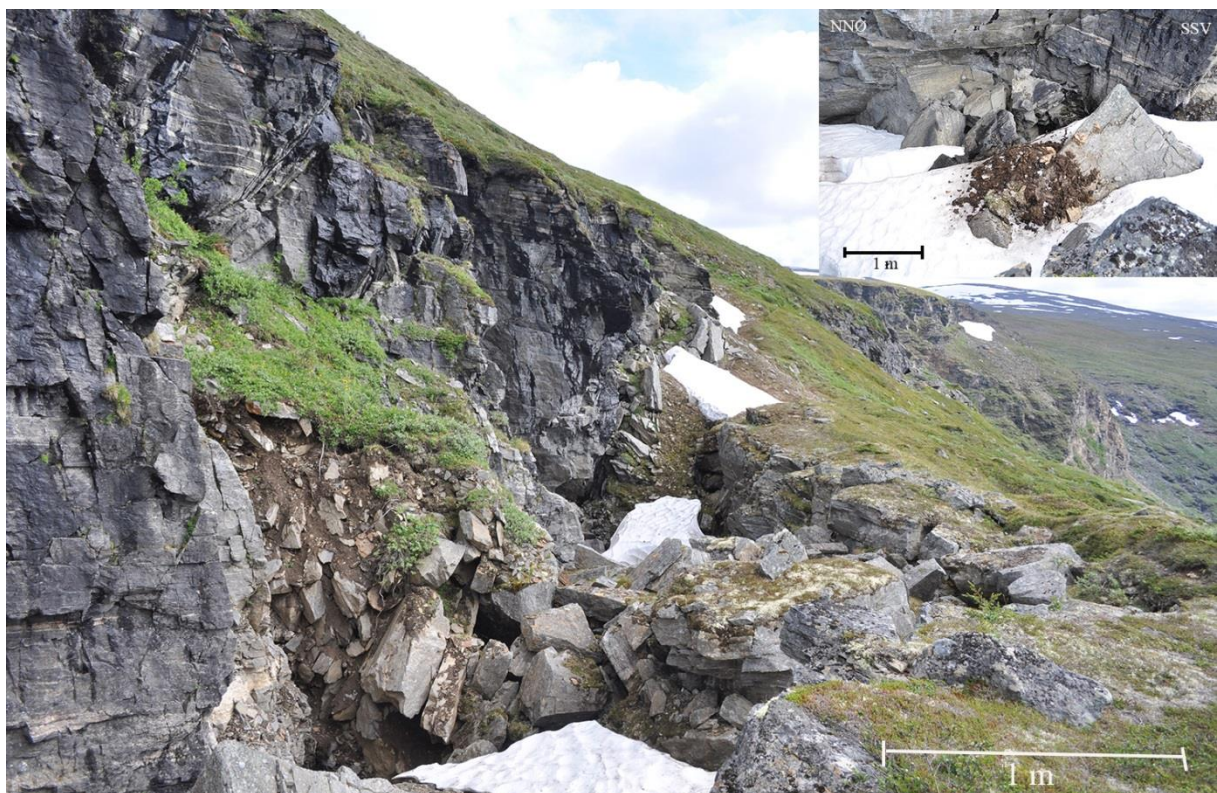
Fig. 36 Syner utraste blokker og skredjord i baksprekka i tillegg til akkumulasjonar av snø. Figuren oppe til høgre syner nyleg utrast materiale i form av skredjord (Tabell 1) ettersom massane er avsett oppå snø akkumulasjonen i sprekkelopninga
