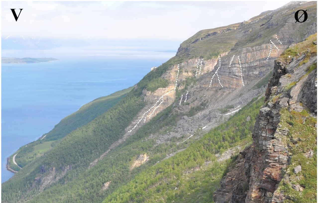
Fig. 52 Syner sprekkutvikling på mesoskala langs den vestvendte fjellsida til Nordnesfjellet der sprekkutviklinga er markert med stipla linjer sett i frå skredområde Indre Nordnes mot Midtre Nordnes og Jettan i mot nord
