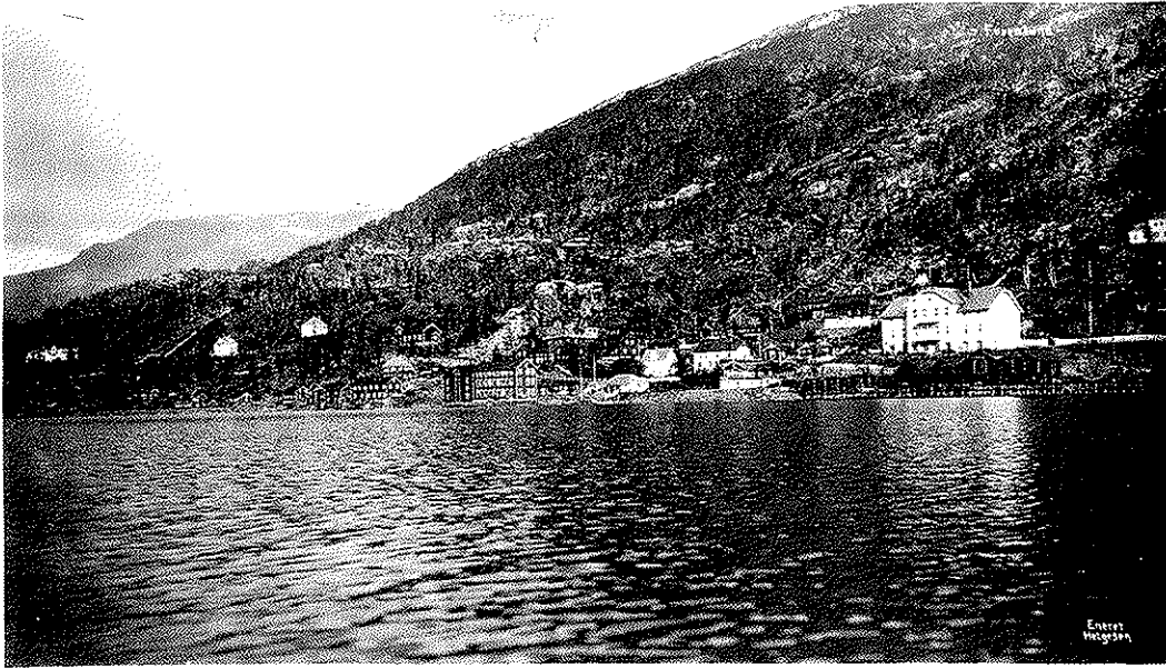
Utsikt over Furulund, ca. 1917. Sykehuset er midt på bildet under en fjellhammer. Helt oppe til høyre sees Lasarettet.
