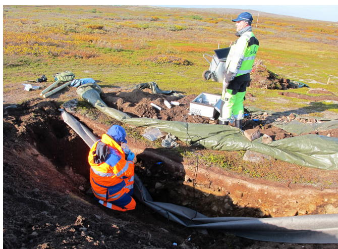
Figur 80 Installasjon av overvåkingsutstyr i Tuft 1 på id. 18734. 19.9.2014
