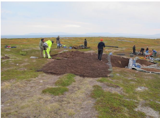
Figur 78 Geotekstil legges på kjøresporet på id. 18734 for å holde på plass masser. 18.9.2014
