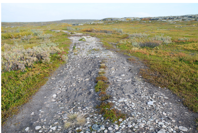
Figur 70 A888 etter gjenlegging. Sett mot N. 15.9.2014
