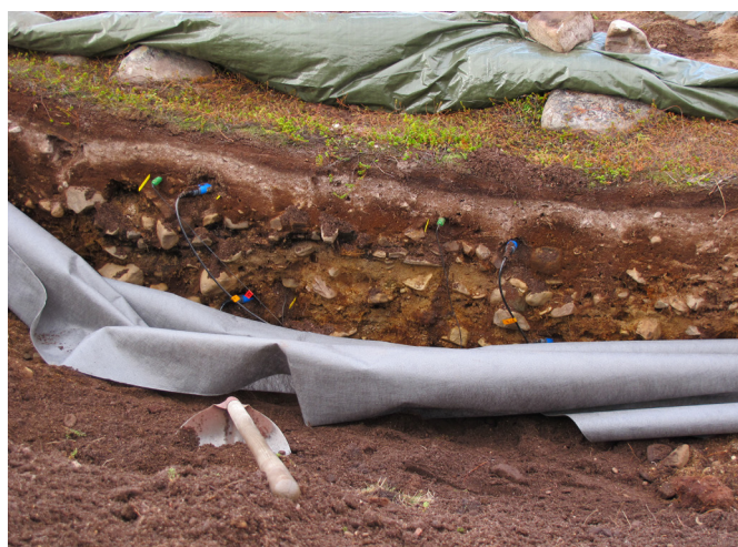
Figur 81 Overvåkingsutstyret er installert og profilen skal legges igjen. 19.9.2014
