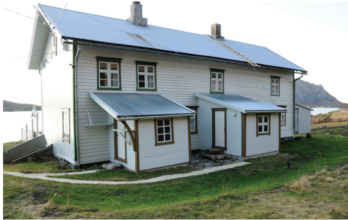
Ill. 3. Fredet våningshus på Tinden i Øksnes kommune. Opprusting av bislag og moderne tilpasset adkomst har medført ugjenkallelig ødeleggelse av gårdshaugens kulturlag. Foto: R. Bertelsen, november 2009.
