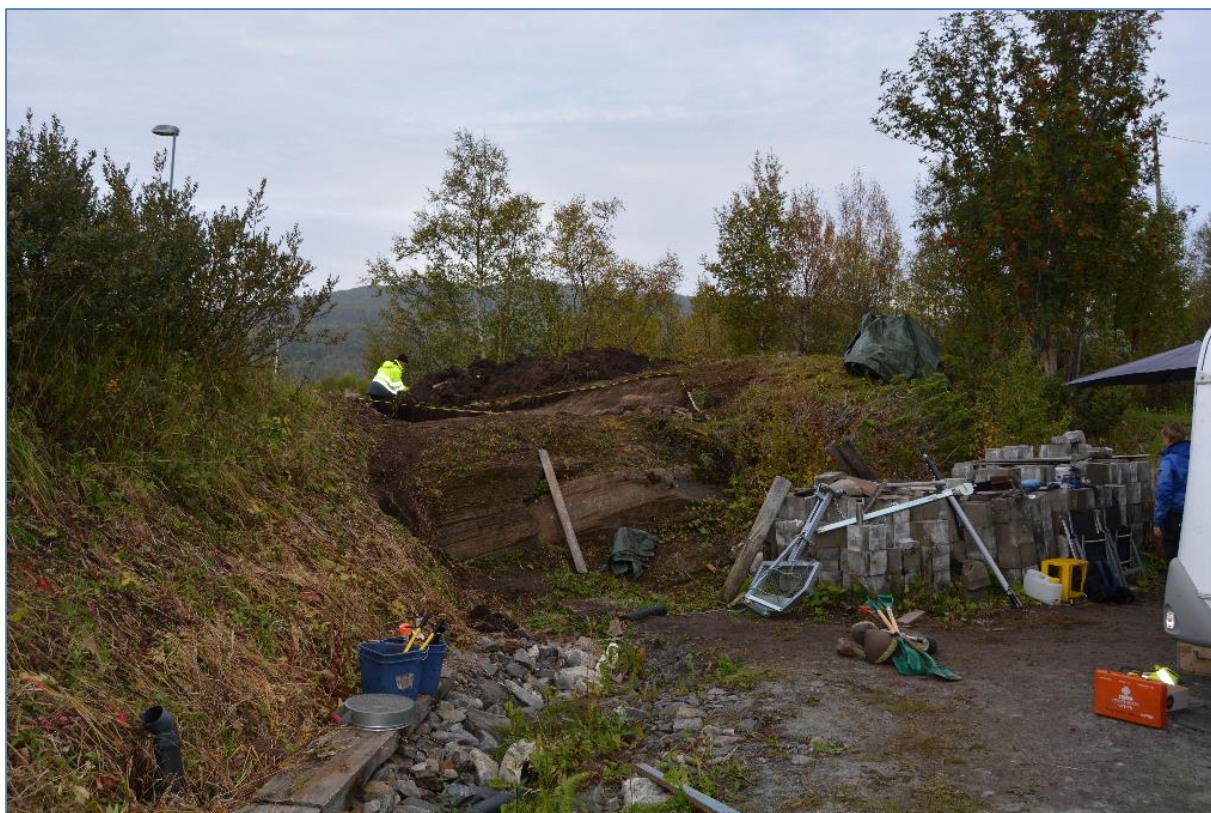
Figur 3. Foto mot vest som viser den oppbygde hekken (til venstre i bildet) samt utgravingsområdet (opp i bildet). Legg merke til høydeforskjellen fra dagens parkeringsområde.
