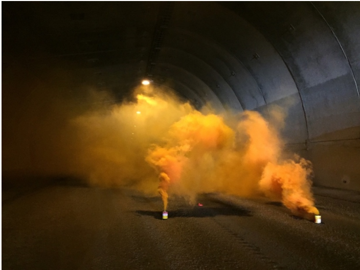
Figur 12 Test av brannventilasjon med røyk i Breivikatunnelen
